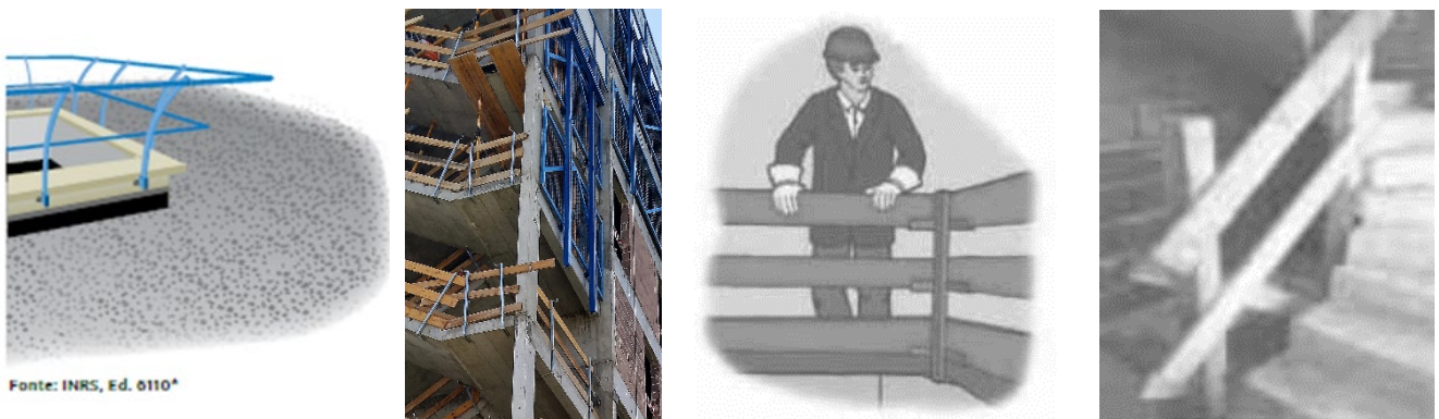
Fig. 31 – Guarda-corpos montados sobre coberturas e sistema de linha de vida montado sobre cobertura
